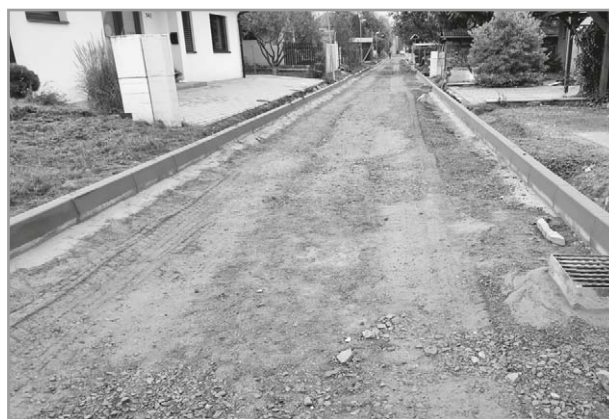
Nová silnice a sítě v ulici Pod Zahrádkami
