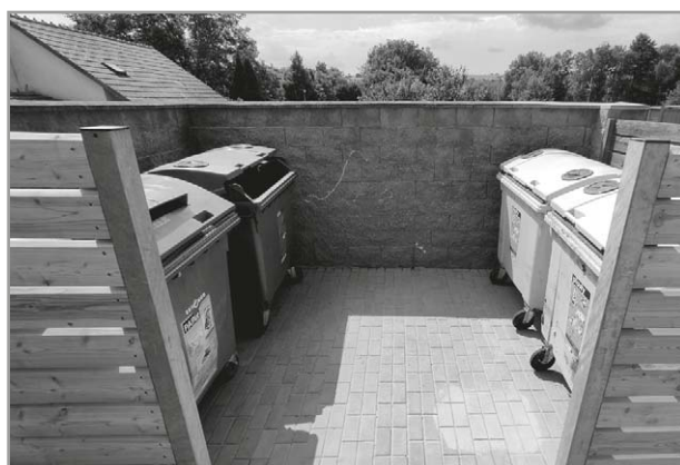
Kontejnery na odpad pod hasičskou zbrojnicí
