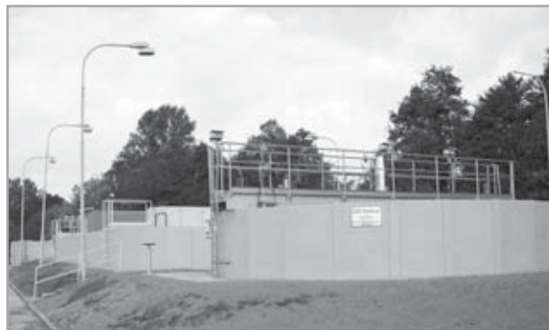
Čistírna odpadních vod po rekonstrukci.
