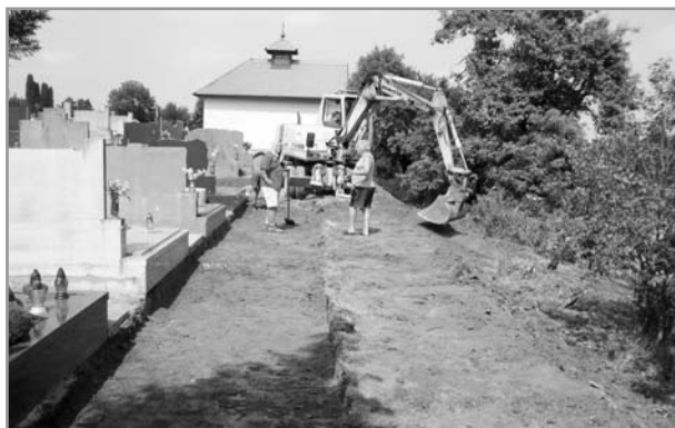
Zahájení výstavby nového chodníku na hřbitově a oplotení.
