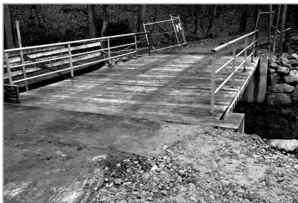
Rekonstrukce mostu - cyklostezka na Salaš
