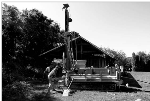
Závalha hřiště - výstavba studny
