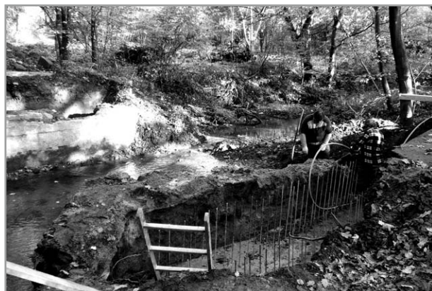
Rekonstrukce mostu - cyklostezka na Salaš
