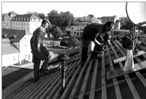
Rekonstrukce střechy mateřské školy
