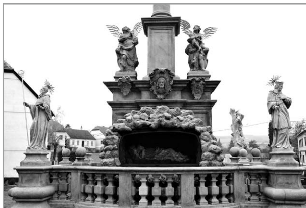
Oprava Mariánského sloupu
