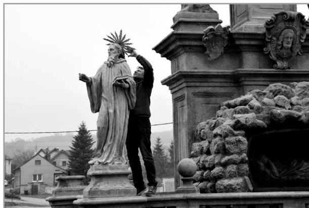
Oprava Mariánského sloupu
