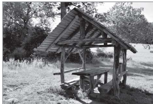
Opravený altán u rybníku v Kotli
